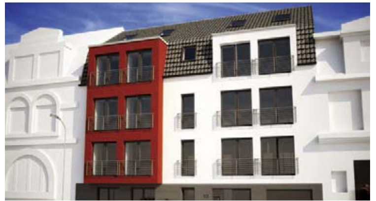
Links: Michael Otto und Christoph Siemes, Rechts: Der Neubau an der Humboldtstraße.
