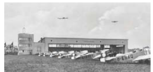
Die große Flugzeughalle auf dem Flugplatz M.Gladbach 1937.
