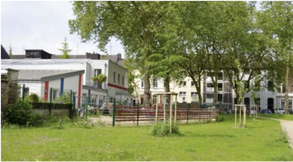
Durch Neugestaltungsmaßnahmen hat das Familienzentrum „Mummi“ am Hugo-Junkers-Park mehr Platz bekommen.
