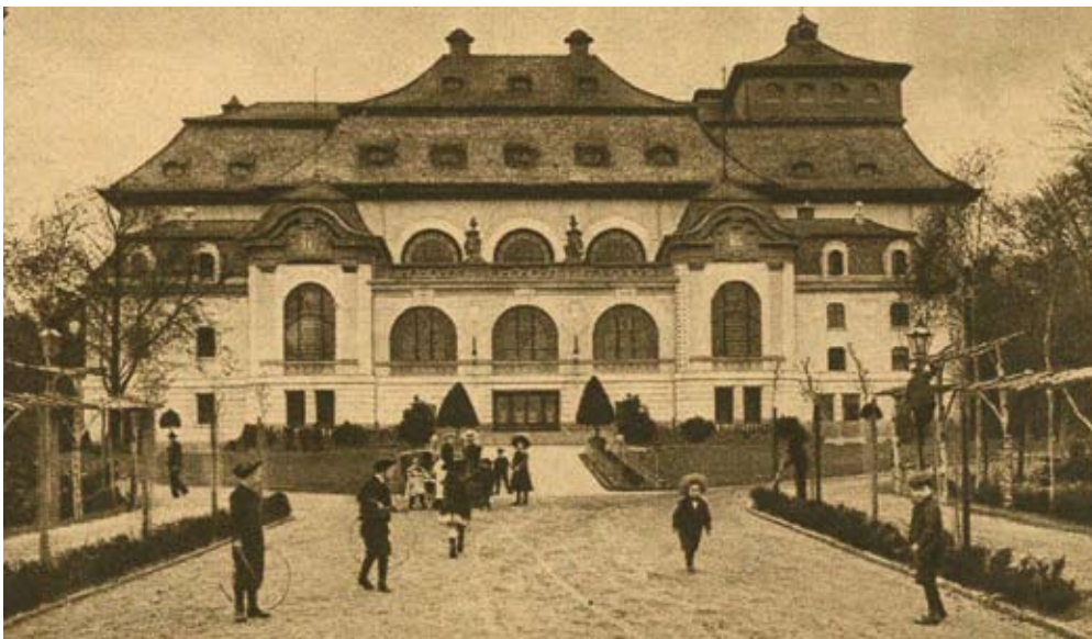
Blick auf die Kaiser-Friedrich-Halle nach Entfernung der Gleisanlagen (ca. 1915).
